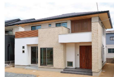
おらかな奇棟の屋根に、格子や明かり採り窓がアクセントになった外観。
