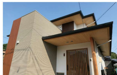
屋根まで続く縦格子とタイルがひときわ目を引く外観。
