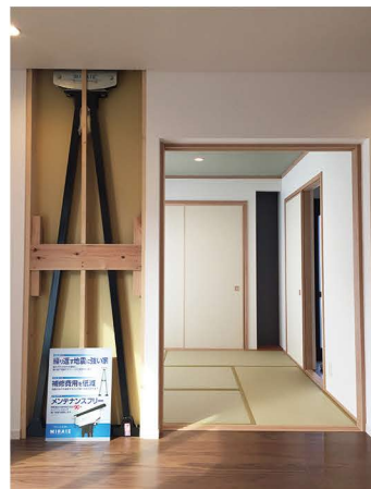
地震による建物の揺れを抑制する「制震ダンパー」。
