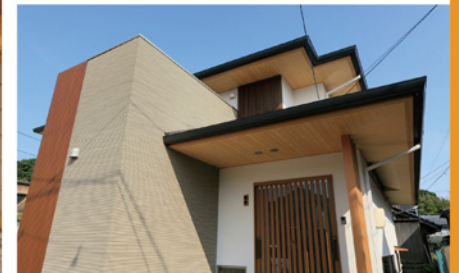
屋根まで続く縦格子とタイルがひとときを引く外観。
