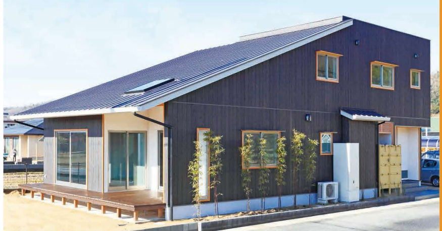
片勾配の大きな屋根と、黒い焼き板の外壁がひととき目を引く和モダンな外観。
