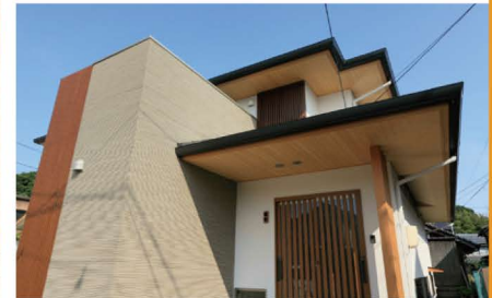
屋根まで続く縦格子とタイルがひときわ目を引く外観。
