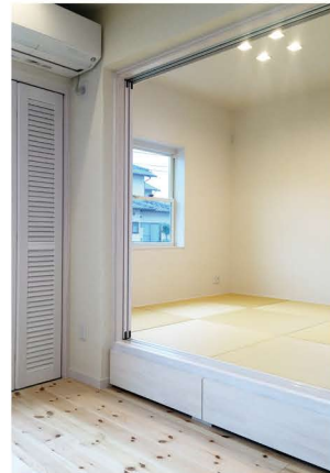
小上がりの和室の下部は引き出し収納に。
