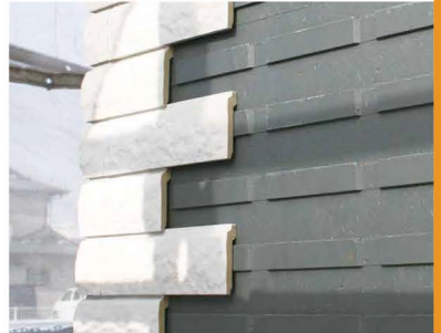
タイルは引っ掛けながら貼るので、落下の心配もなく安心。
