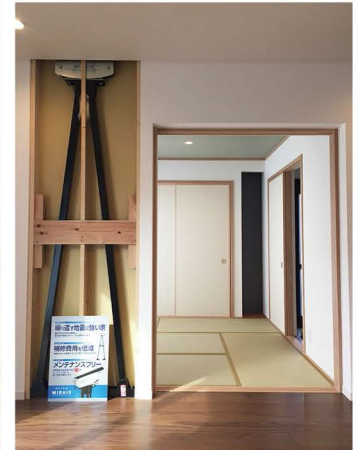
地震による建物の揺れを抑制する「制震ダンパー」。
