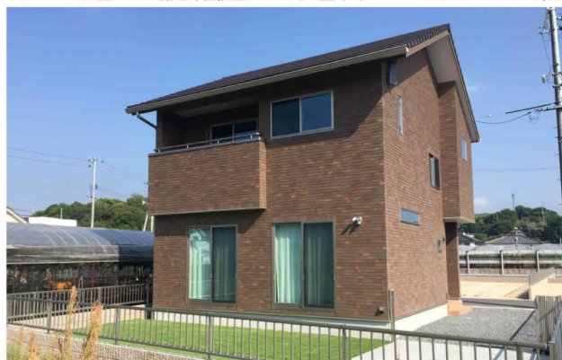
メンテナンスフリーでキレイがずっと続く総タイル貼りの外壁。
