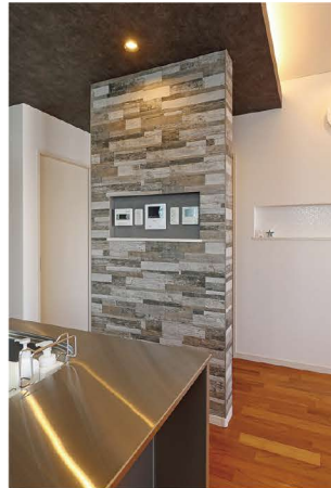
キッチン横のアクセント壁には木枠コンクリート調のタイルを使用。
