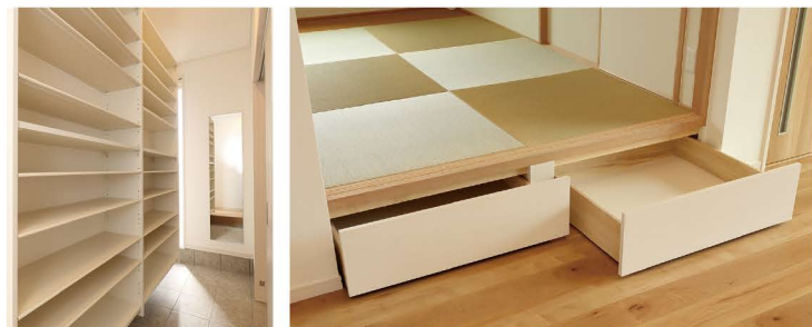
玄関から直接出入りできる広々土間収納。和室の下は引き出し収納にし、空きスペースを有効活用。
