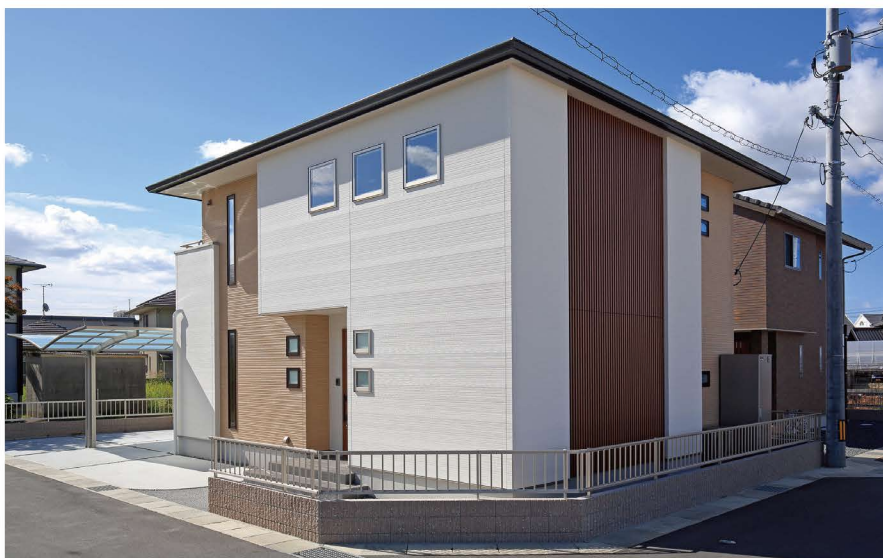
気密性能C値0.4+制震ダンパー標準装備の高気密・高断熱・高耐震な認定低炭素住宅。よく見える道路側には木目の縦格子を設置しアクセントに。
