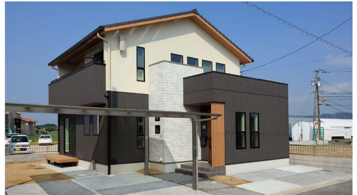
玄関ポーチにはアクセントにもなる木調格子を設け、プライバシーに配慮。
