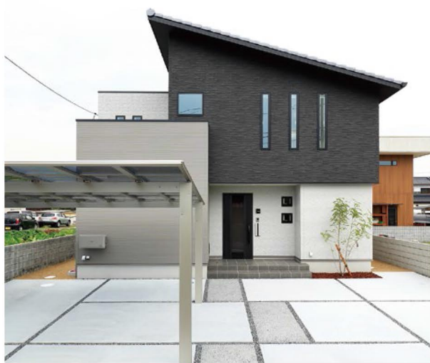
モノトーンカラーのグラデーションがシンプルモダンな外観を演出。屋根には太陽光設備も完備。
