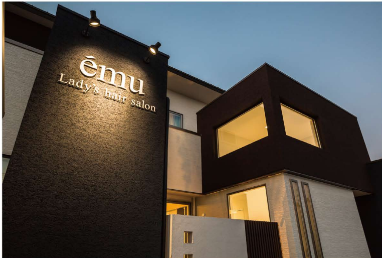
住居と美容室の機能を併せ持つ店舗併用住宅。立体的なフォルムが絶妙なバランスで融合する高級モダンな外観。
