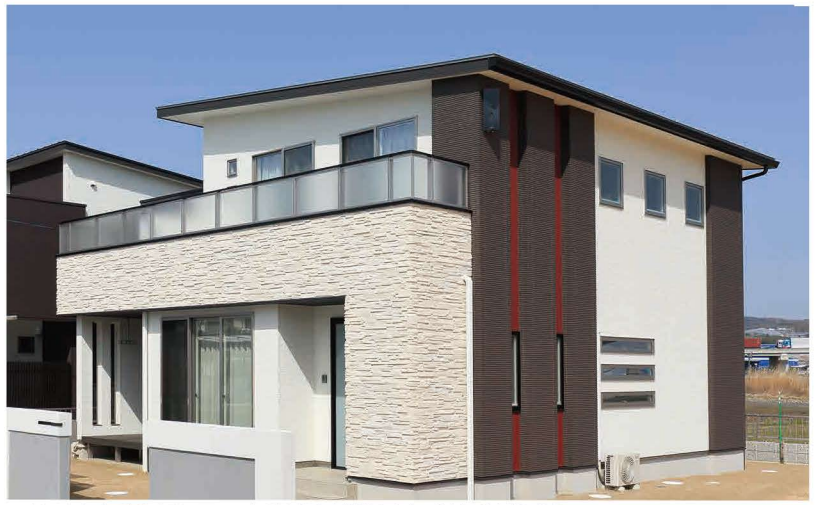
アクセントタイル貼り・玄関正面にL型に貼られた立体的なタイルが高級感を醸し出す。
